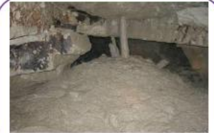
Comblement par déversement gravitaire
