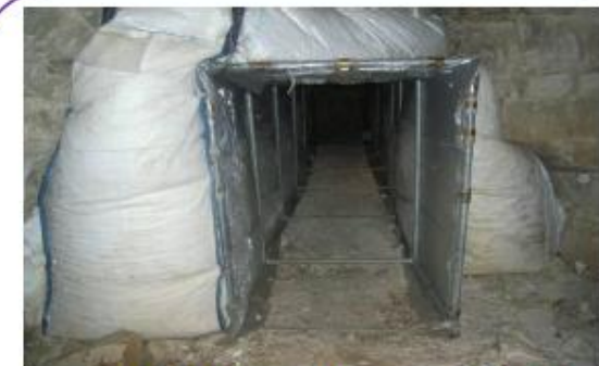
Tunnel édifié à travers de la mousse expansive et permettant de maintenir un passage
