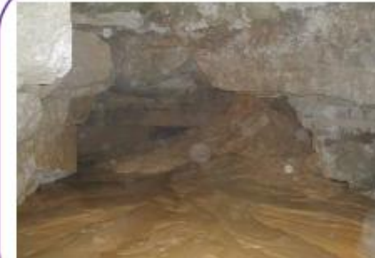
Comblement par coulis de silicates
