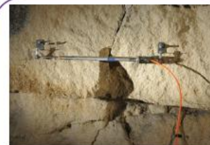
Surveillance par fissuromètre
